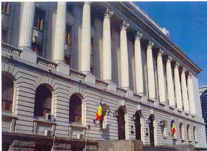
București, Noul Palat al BNR Str. Doamnei nr. 8 (fațada)
