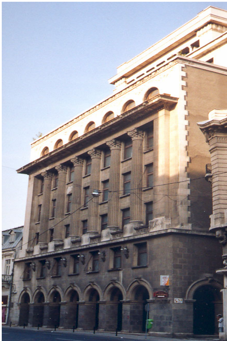
București – Casa de Pensiuni a Funcționarilor BNR, Calea Victoriei nr. 22
